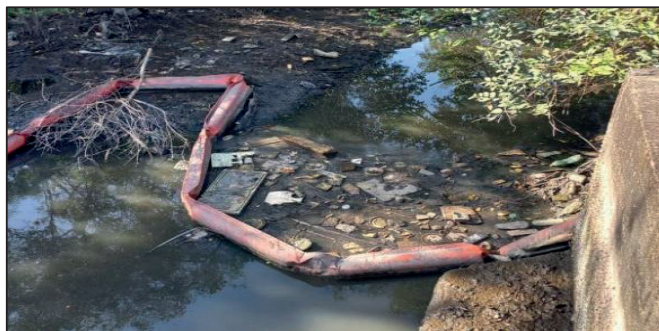
Figura 6 - Ecobarreira instalada em São Vicente
