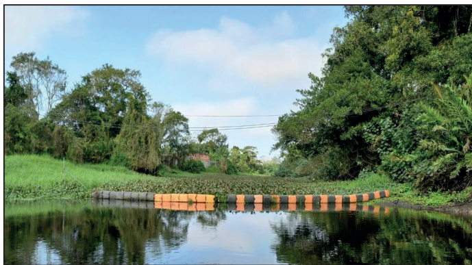
Figura 12 - Ecobarreira instalada em Praia Grande, no bairro Samambaia
