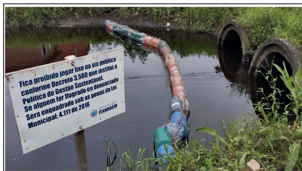
Figura 4 - Ecobarreira instalada em Itanhaém
