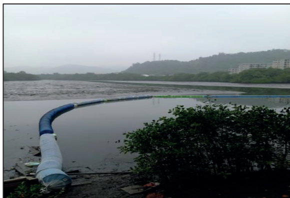
Figura 8 - Ecobarreira instalada em Santos
