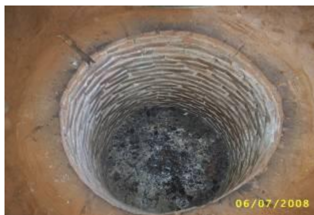
Figura 3: Buraco com 6 metros onde fica o tacho.
