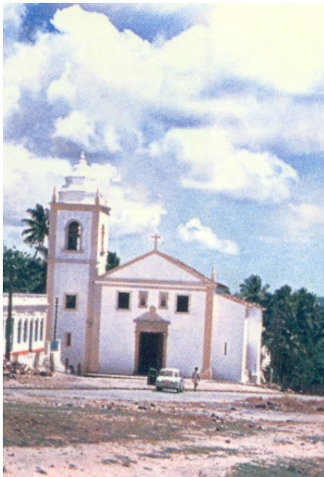
Igreja dos Ss. Cosme e Damião (Igaracu, PE)
