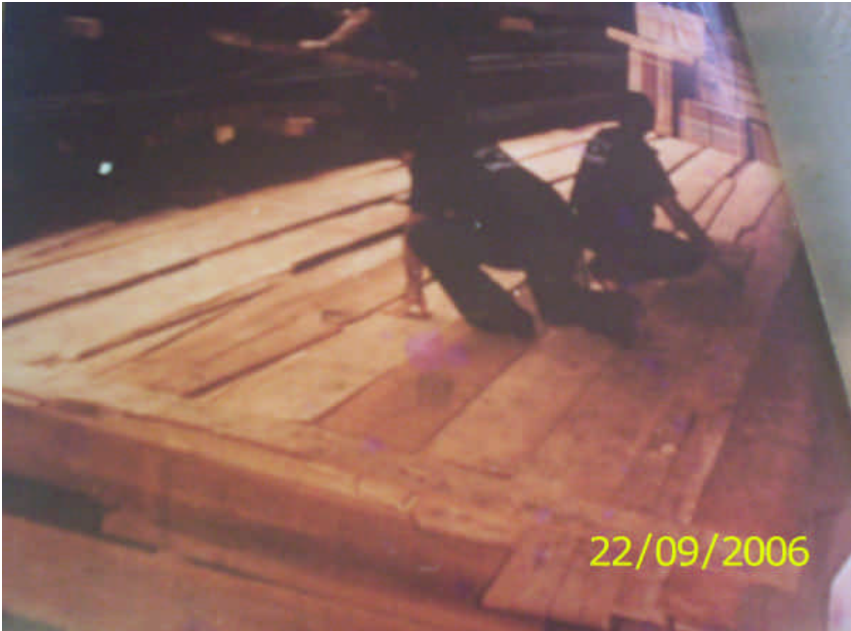
Foto 4 : Forramento de madeiras em geral.
