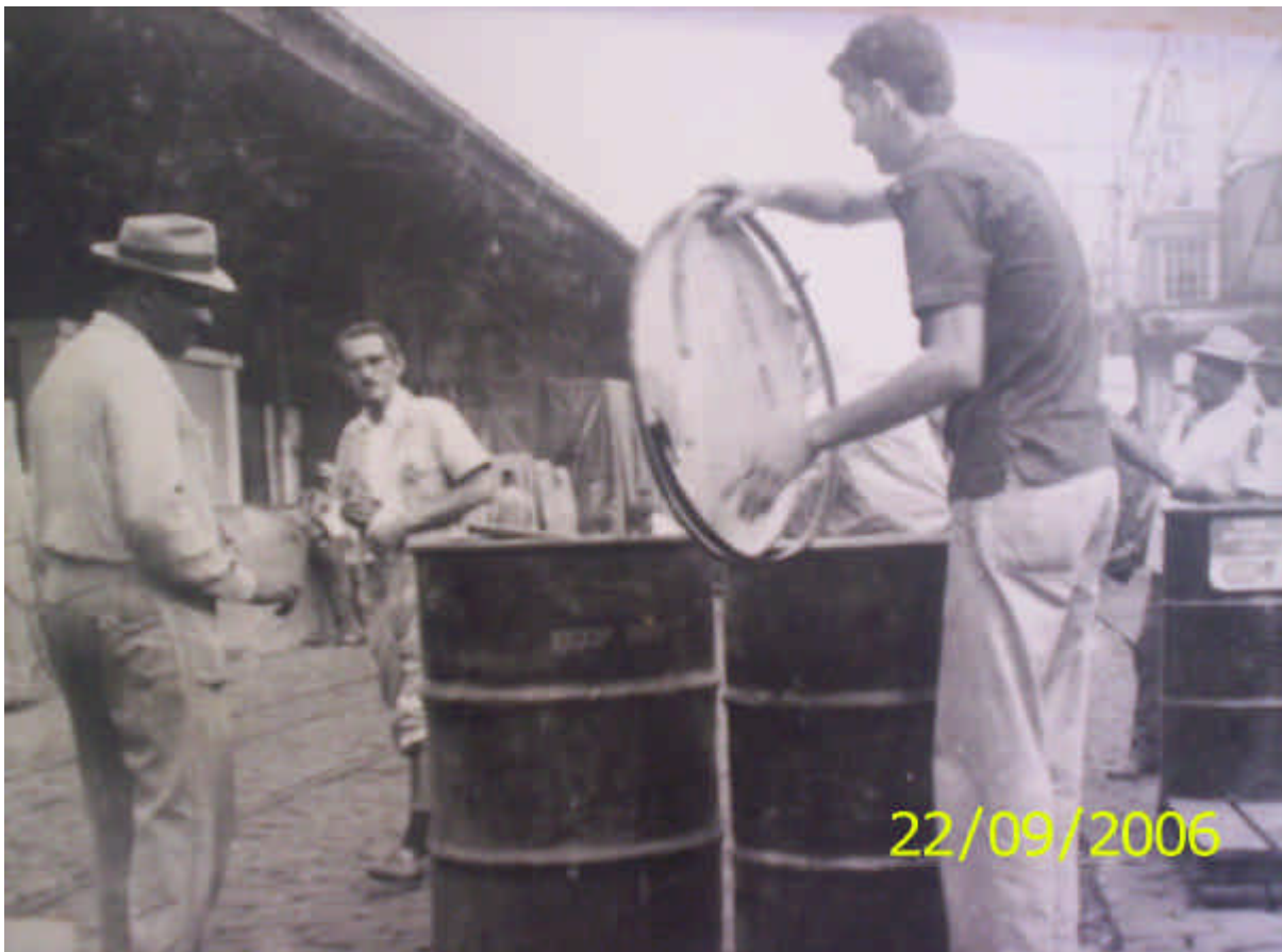
Foto 1 :Realização de reparos (cintamento em tambores)
